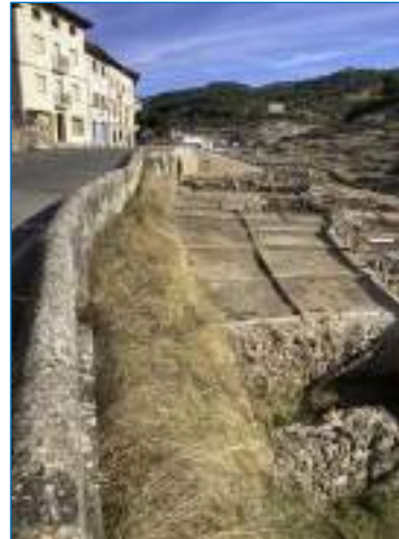
FOTO ZONA AFECCIÓN 2
